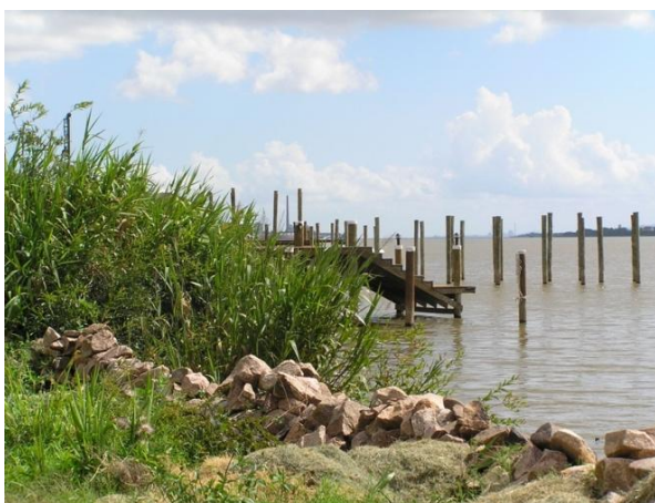
Figura 25: Construção de piers . Data: Junho de 2007. Fonte: Ecléa Morais.
